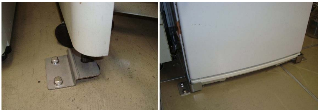
図2 実験機器の床面への固定法
