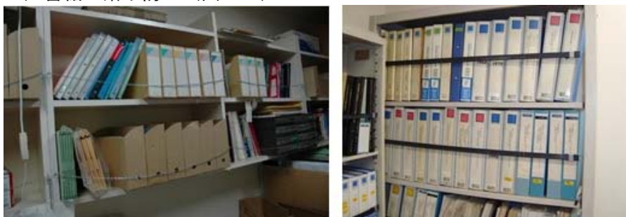
図15 （左）チェーン、（右）ベルトによる書棚の落下防止。
