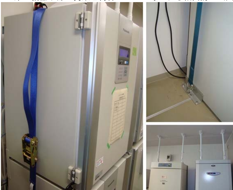
図5 （左）荷締めベルトと底部ブラケットによるインキュベーターの固定。（右上）ア
