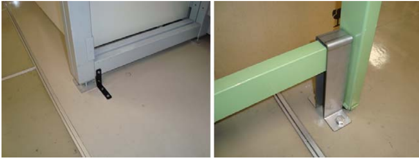
図1 実験台の床への固定
