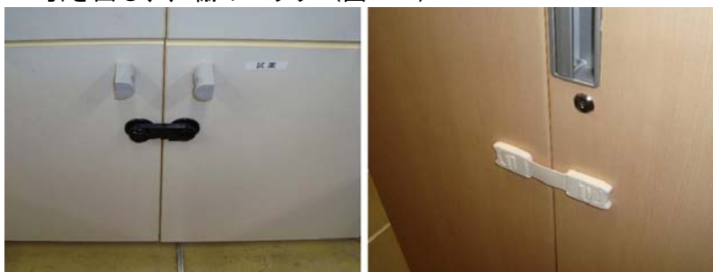
図13 収納庫引き戸のロック 市販の耐震用品。両面粘着材で取り付け。
