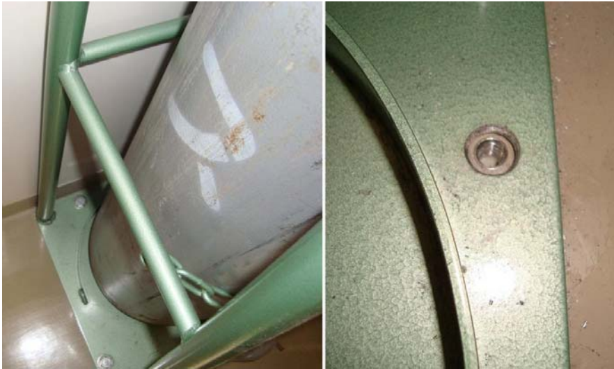
図3 ガスポンベスタンドの床面への固定。雌ネジアンカーの打込み（右）。
