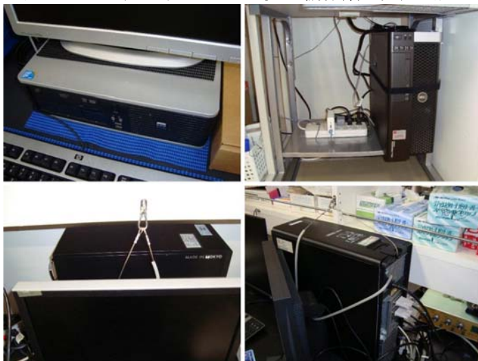
図 16 (左上) ノンスリップマットによる滑り防止。(右上) ベルクロバンドによるラックへの固定。(下段) ワイヤーによるワークステーション、ディスプレイの転倒、落下防止
