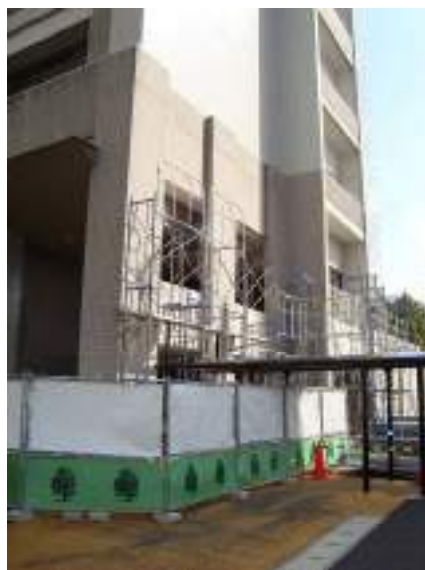
図. 建物修復工事が開始される
