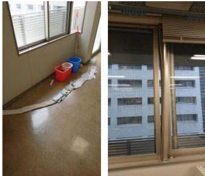
図. 窓枠は変形し雨水の浸水も起きた
