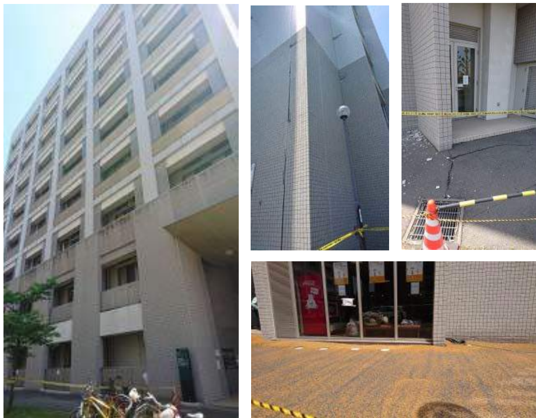
図. 発生研建物外壁のタイルは剥がれ、内壁にまで貫通する亀裂などの損傷が発生。地面が凸凹となって段差が見える。
