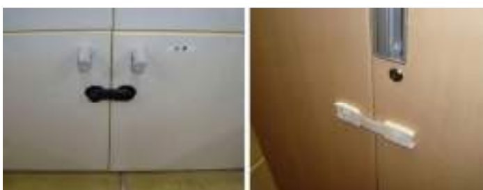
図13 収納庫開き戸のロック 市販の耐震用品。両面粘着材で取り付け。
