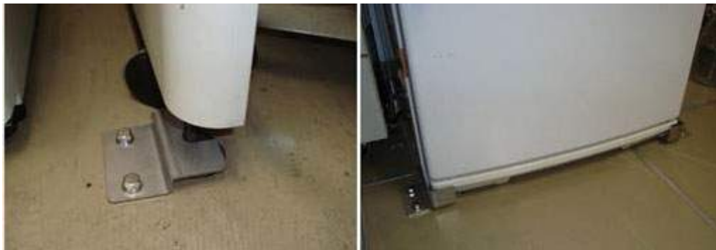
図2 実験機器の床面への固定法
