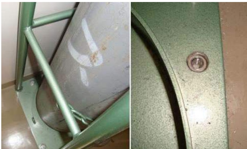
図3 ガスボンベスタンドの床面への固定。雌ネジアンカーの打込み(右)。
