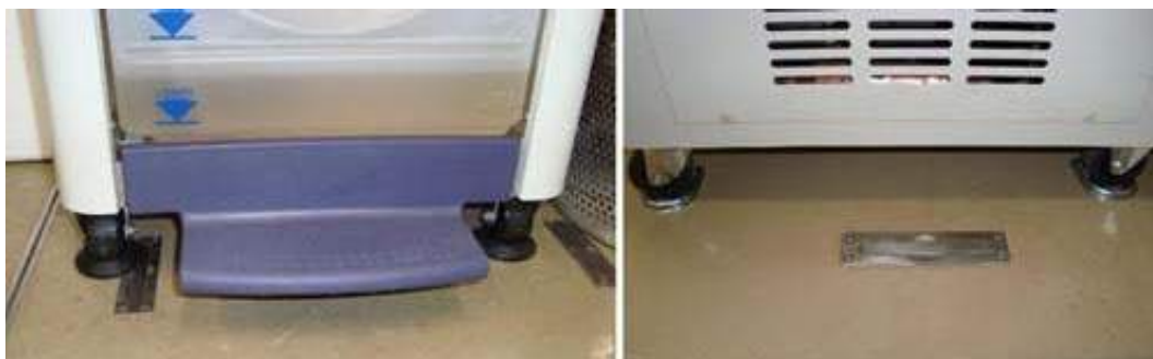
図4 輪留めによる固定
