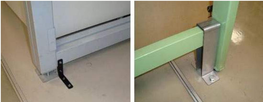
図1 実験台の床への固定
