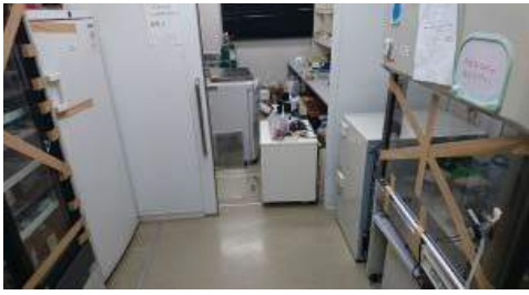
図. 続く余震に備え、一時的な固定
